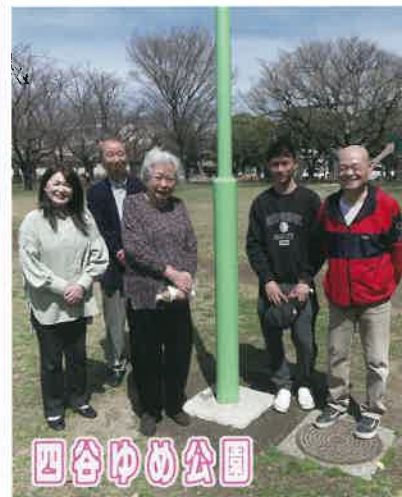
根元に穴が開いた公園灯の支柱を交換
