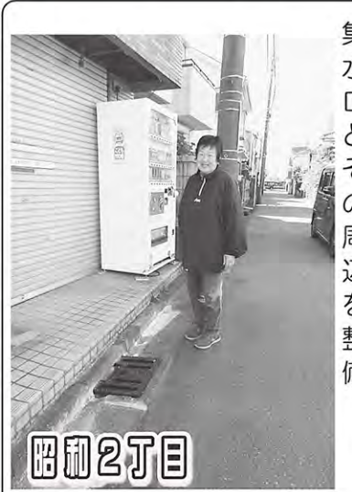
雨水が流れやすくなるように集水口とその周辺を整備
